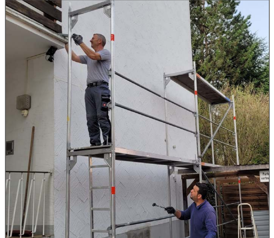
Dış cephe uygulaması – Bad Wörishofen
