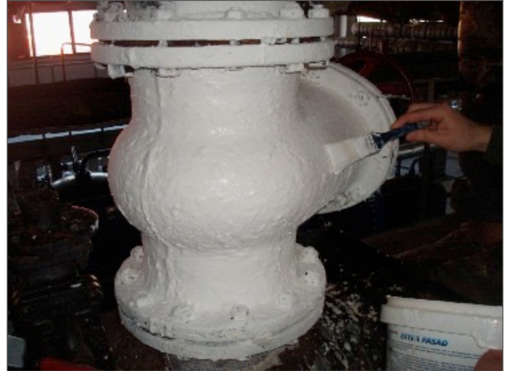
Sıcak boru hattı / Kanada
