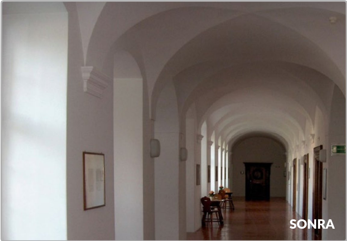
Tarihi Bina Restorasyonu - Huthhrum
